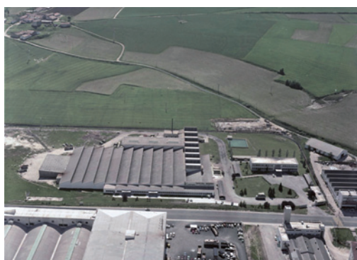
PAPELERA DE NAVARRA: Instalaciones de Karpan Papelera Navarra en Cordovilla. (1972) Fototeca del Archivo General de Navarra. ES/NA/AGN/F432/FOT_FOAT_3788
