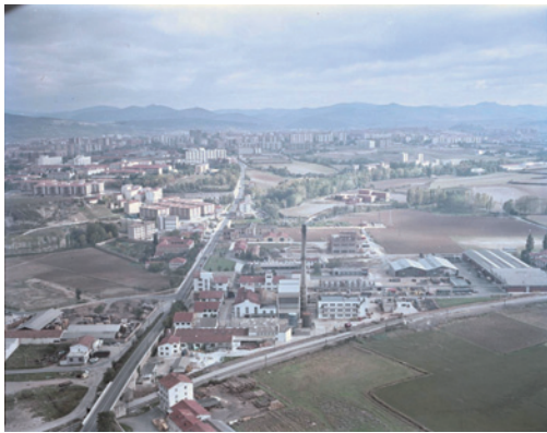
INQUINASA: Instalaciones en Pamplona (1974). Fototeca del Archivo General de Navarra. ES/NA/AGN/F432/FOT_FOAT_3814
