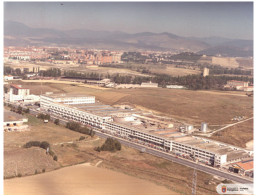
SUPER SER: Junto a Diario de Navarra , en la avenida de Zaragoza (1984). Fototeca del Archivo Municipal de Pamplona Iruñeko AMP002765
